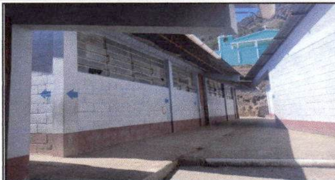
Foto 2: Pintura en muros exteriores e interiores
