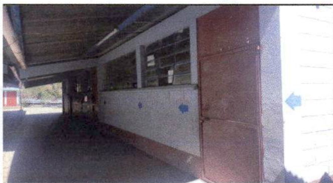
Foto 3: Pintura en muros exteriores e interiores
